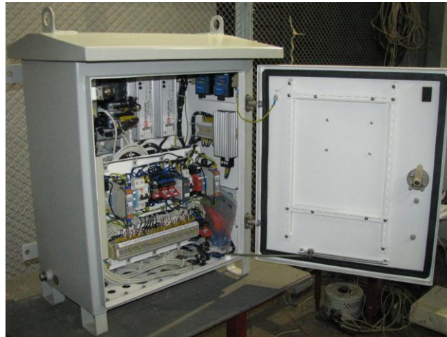
Рисунок 4 – Шкаф сопряжения полупроводникового преобразователя
