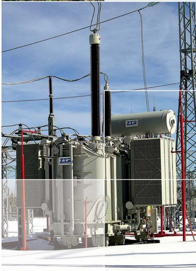
ПАО «Запорожтрансформатор» производит силовые масляные трансформаторы и реакторы мощностью до 1 250 МВА на классы напряжения до 1150 кВ включительно.
